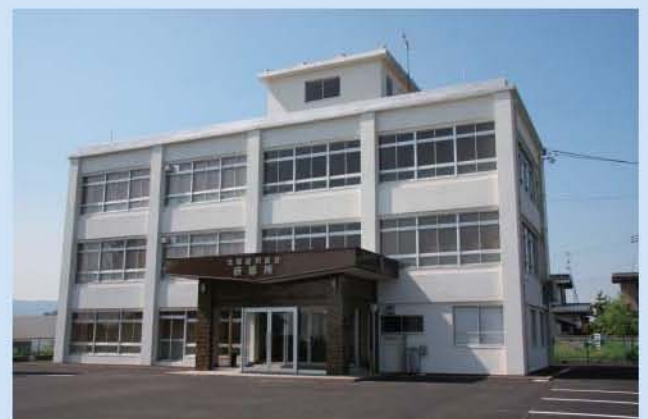
新設された研修所
